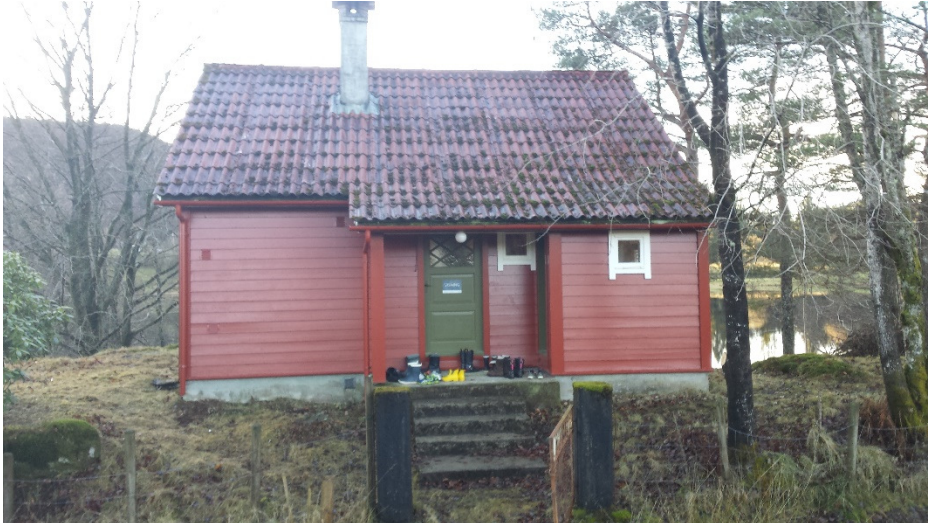
Foto tatt nov 2017 av inngangsparti/østfasade
