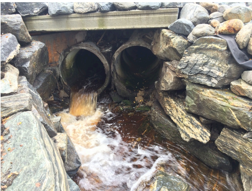
Figur 9. Innløpsbekk nord til Tjukketvatnet fotografert i ein periode med fuktig vêr i oktober. Biletet er teken frå same ståsted som Figur 8, men tatt i mostatt retning. Legg merke til at nivåforskjell mellom kultvert og bekk hindrar fri fiskevandring. Foto: Uni Research (G. Velle).
