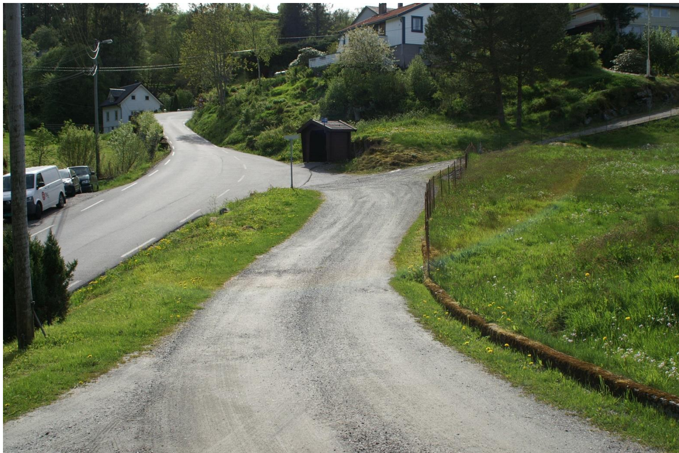
Fylkesvegen ved framtidig avkjørsel til veg f_V1.
