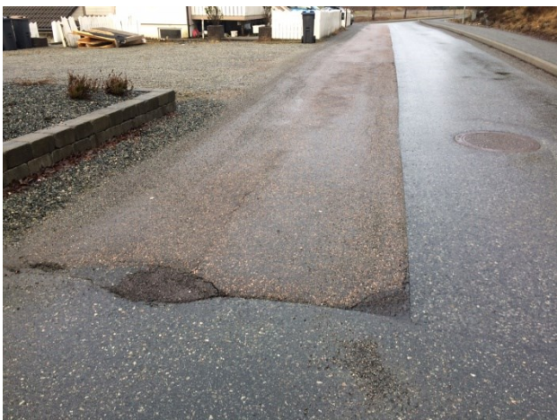
Figur 1 Følgeskadar på 8 år gammalt gravearbeid. Vegdekket er frå 2005.
