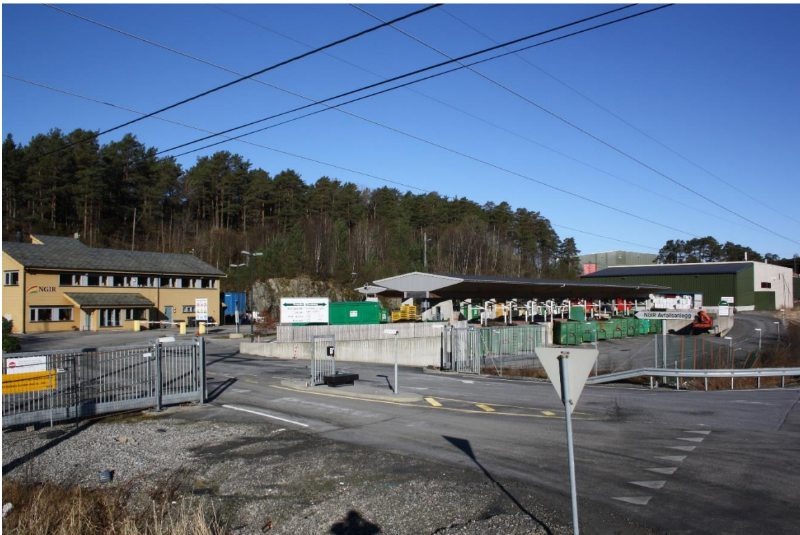
Figur 9: Eksisterande bygg innanfor planområdet.
