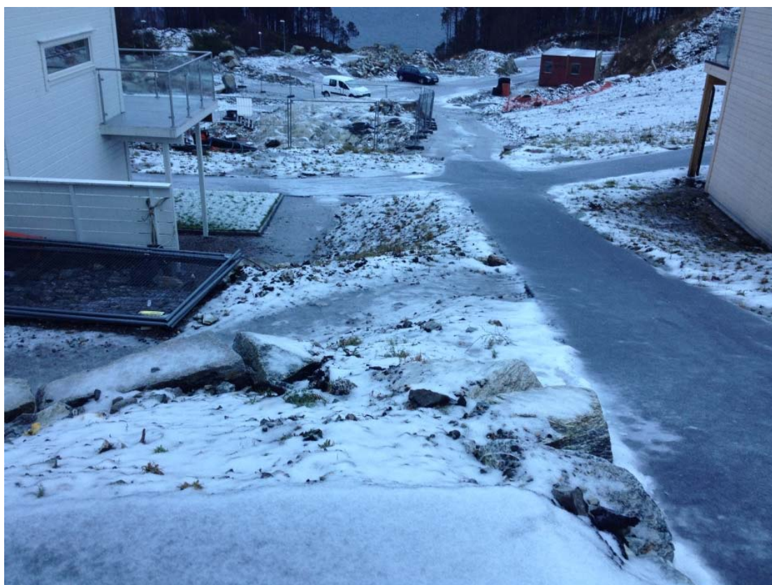
Fig 11. Bildet viser gangsti på oppsiden av husrekke 22-25.
