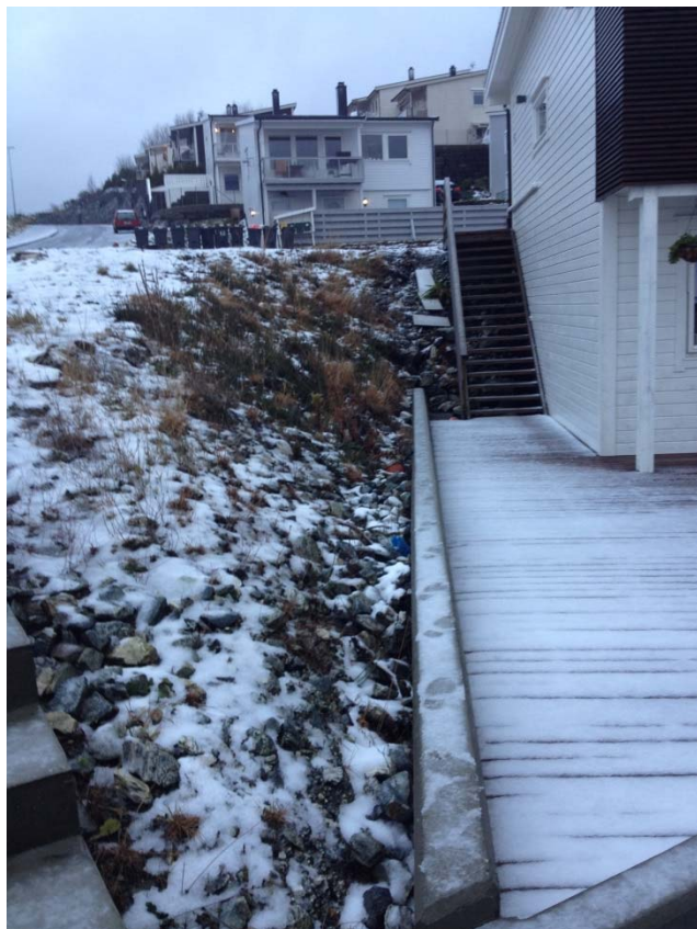
Fig 6. Bildet over viser trapp og terrasse utenfor hus1. Se fig 1 og 2. Dette tiltaket er ikke utført på vegne av tiltakshaver, men sannsynligvis av eier av tilliggende bolig.
