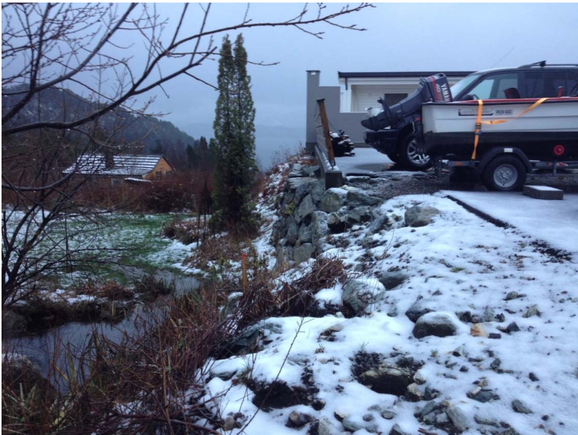
Fig 5. Bildet over viser PS1 og mur mot terrenget.
