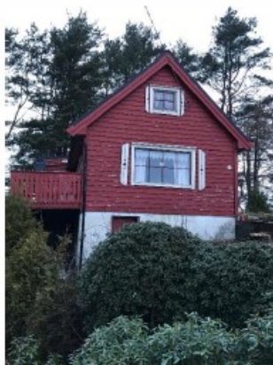
Bilde av eksisterande bygg
