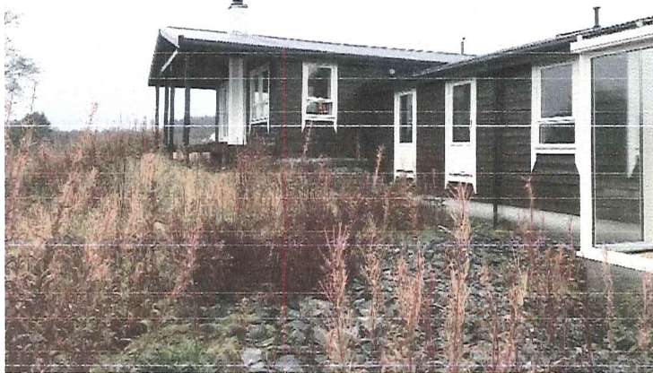
Dagens situasjon sett fra sør-vest. (Vinterhage t.h.)
