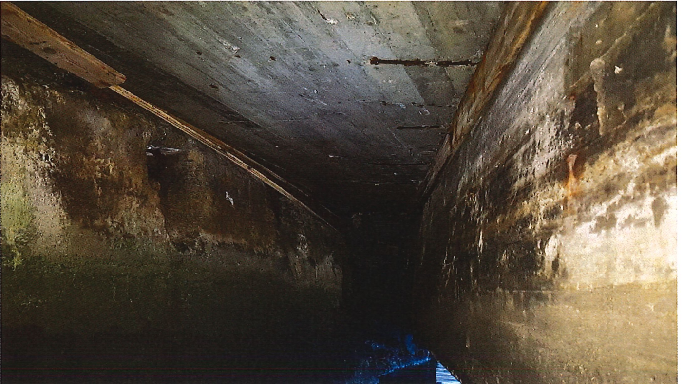
A2 Hviser korrosjon pga. liten eller dårlig overdekning.
