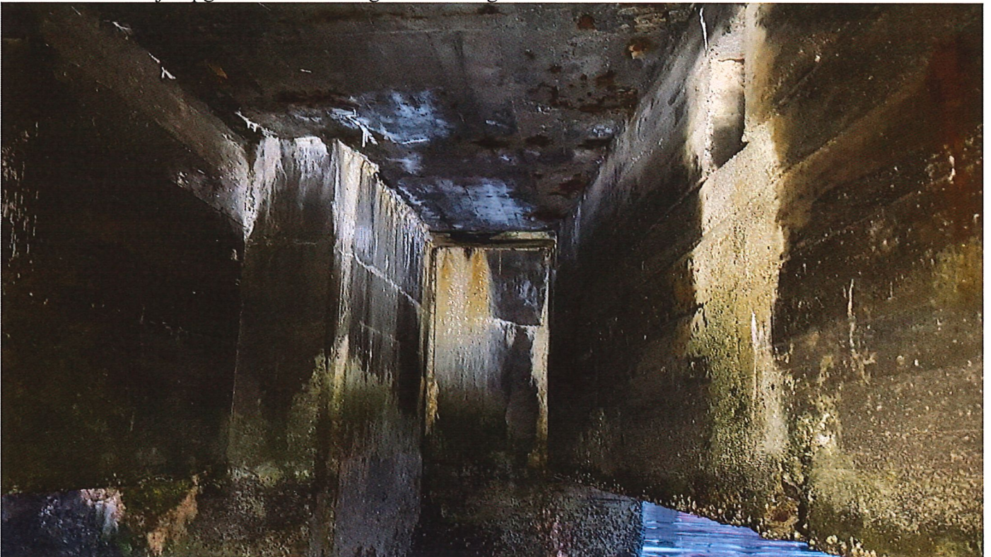
A2 Hviser korrosjon pga. liten eller dårlig overdekning.
