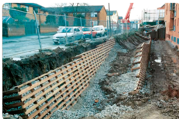
Fig. 7 b Bingemurer av tre for etablering av fortau på et lavere nivå enn veien den ligger langsmed. Foto: www.pccconstruction.co.uk
