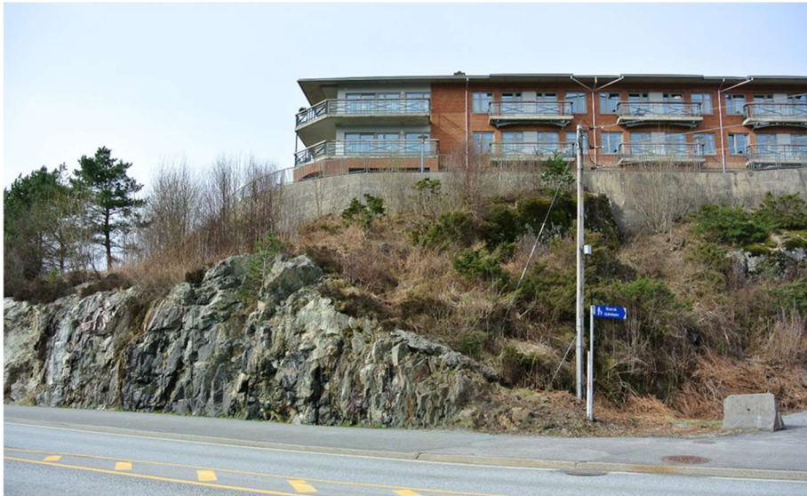
Bilde tatt mot Knarvik sjukeheim viser eksisterande bergskjering og terreng opp mot støttemur. Bildet viser høgaste punkt på eksisterande skjering.
