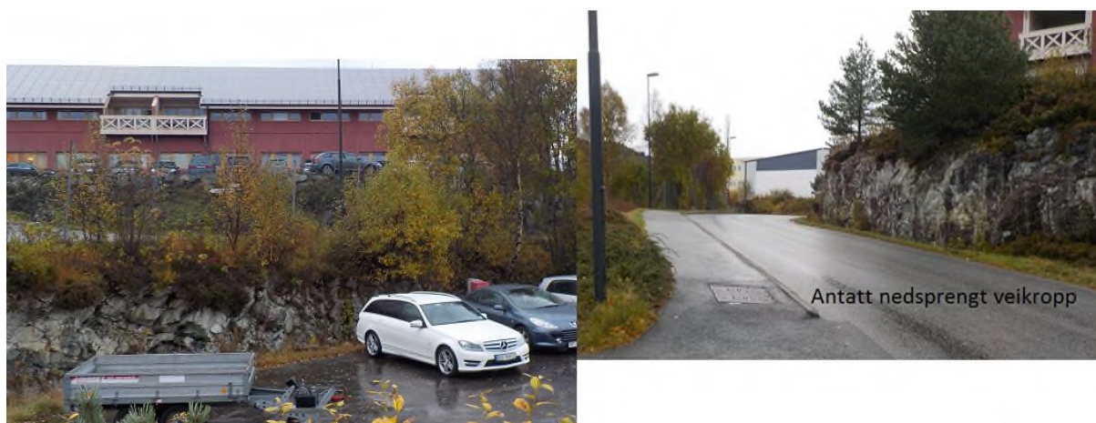
Figur 1. Bilde er tatt i nordlig retning utenfor Kvassnesvegen 37.
