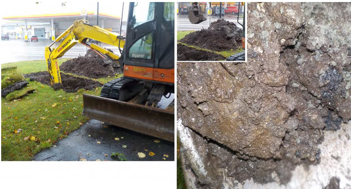
Figur 18. Bildene er tatt under sjakting i punkt 28. Sjakten ble 2,5 m dyp. Flere bilder er tilgjengelig på forespørsel.
