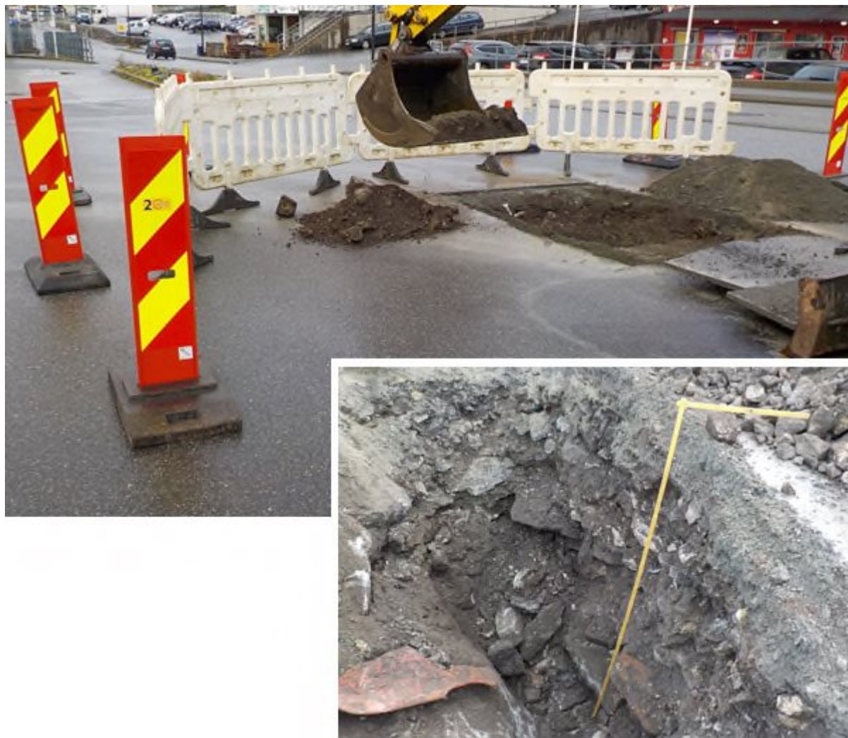
Figur 3. Sjakting i punkt 34. Sjakt P34 ble 1,5 m dyp. Graving avsluttet grunnet store stein og fare for utrasing/setninger på P-plass.
