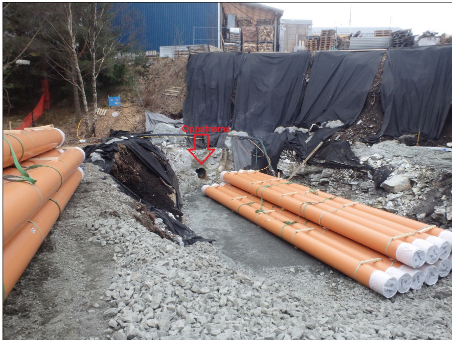
Foto: Oversikt oppstrøms.JPG Om, Start inspeksjon -
