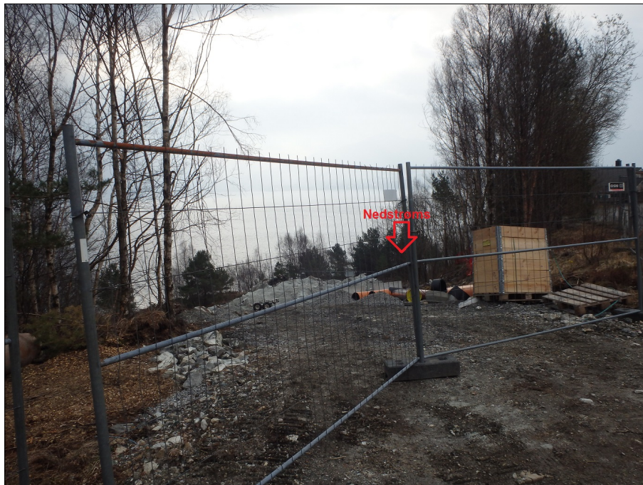
Foto: oversikt nedstrøms.JPG 276,97m, Inspeksjon fullført -
