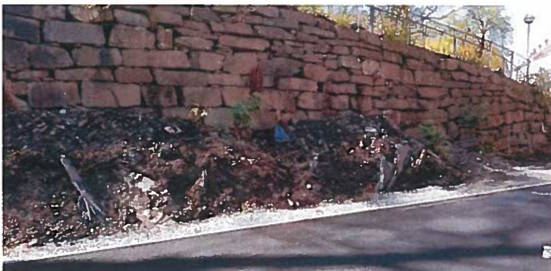
Figur 3-3: Løsmasser langs tørrmur sør i undersøkelsesområdet som ble prøvetatt i PG2. Massene bestod av vekstjord iblandet stein, benyttet som blomsterbed. Det var synlige blotninger av fjell. Foto: Multiconsult
