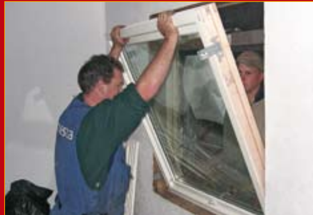
Utskifting til lydisolierende vindauge er eit vanleg støytiltak.
