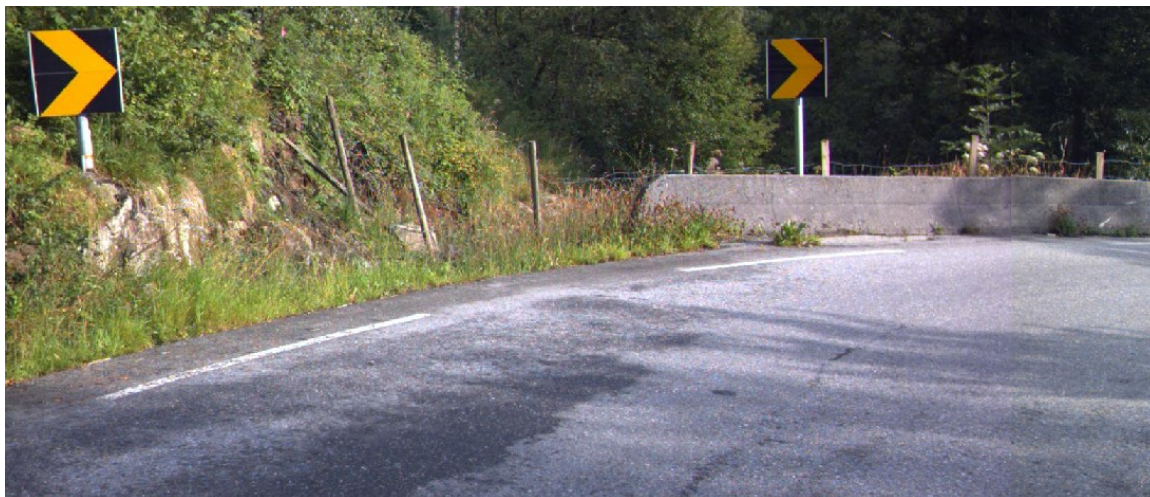
Vegbilette 2010 som syner ei lengre støypekant.
