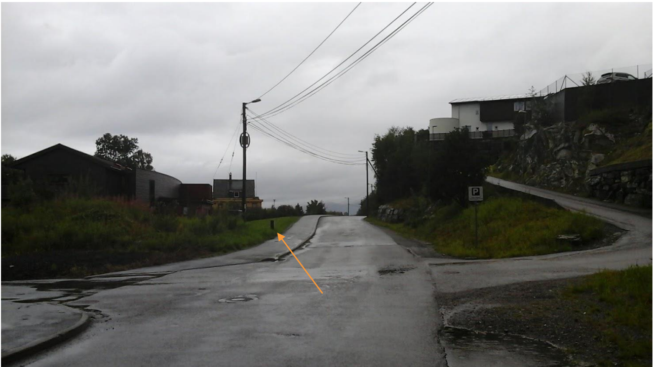
Fordelerskap langs fortau
