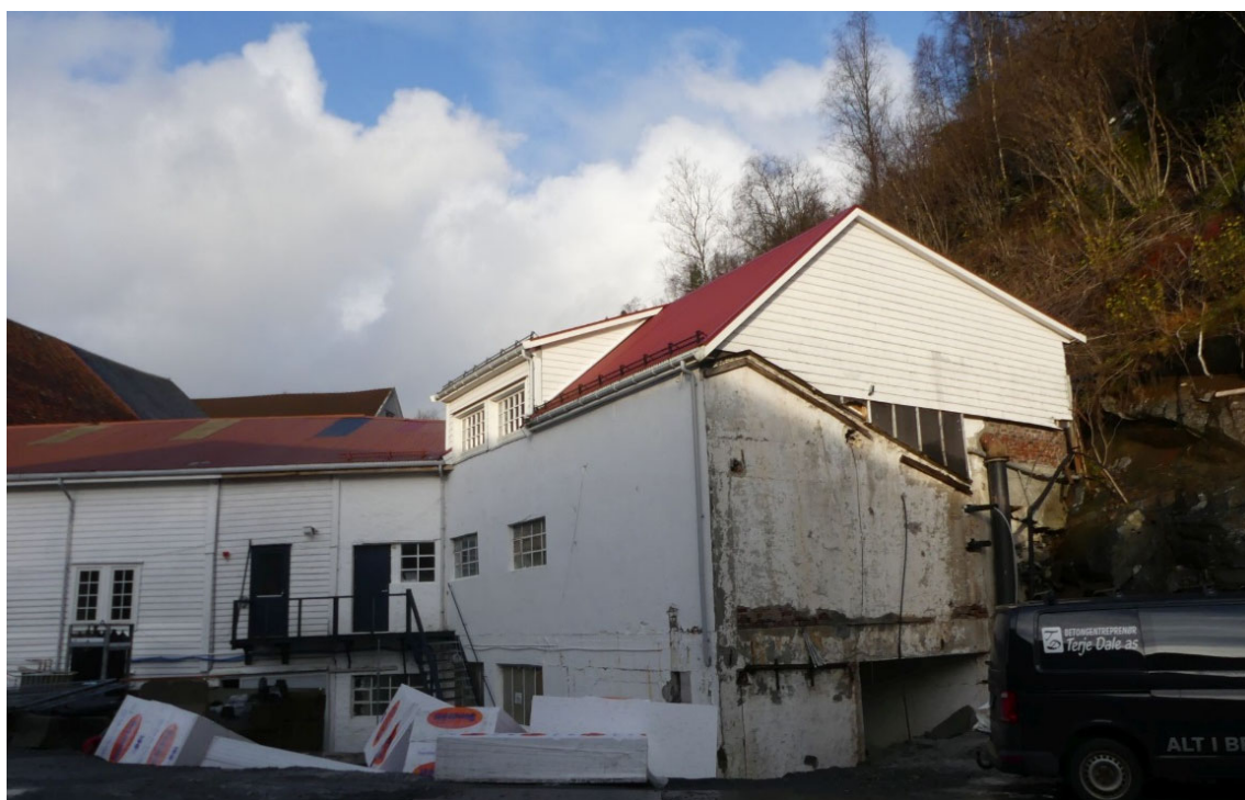
Ishuset sett frå sør. Loftetasjen består av tremateriale. Kjellar og 1. etasje i betong.
