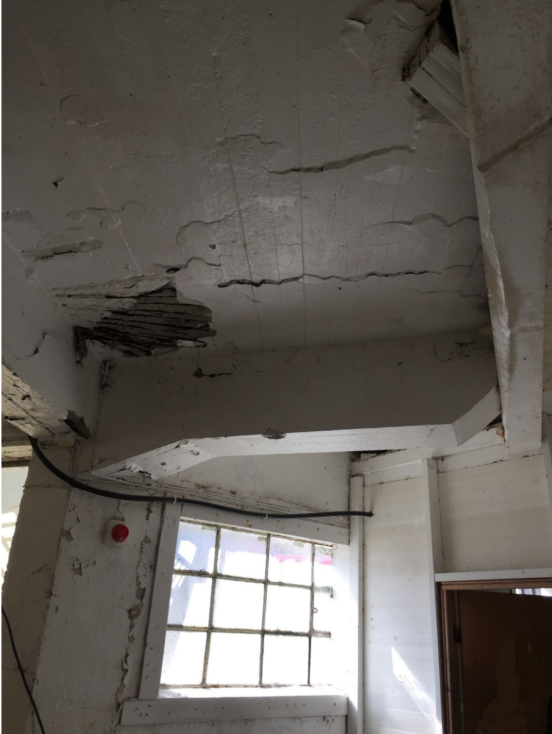
1. etasje. Bæresystem dels i tre og dels i betong. Smårutete vindauger i metall.
