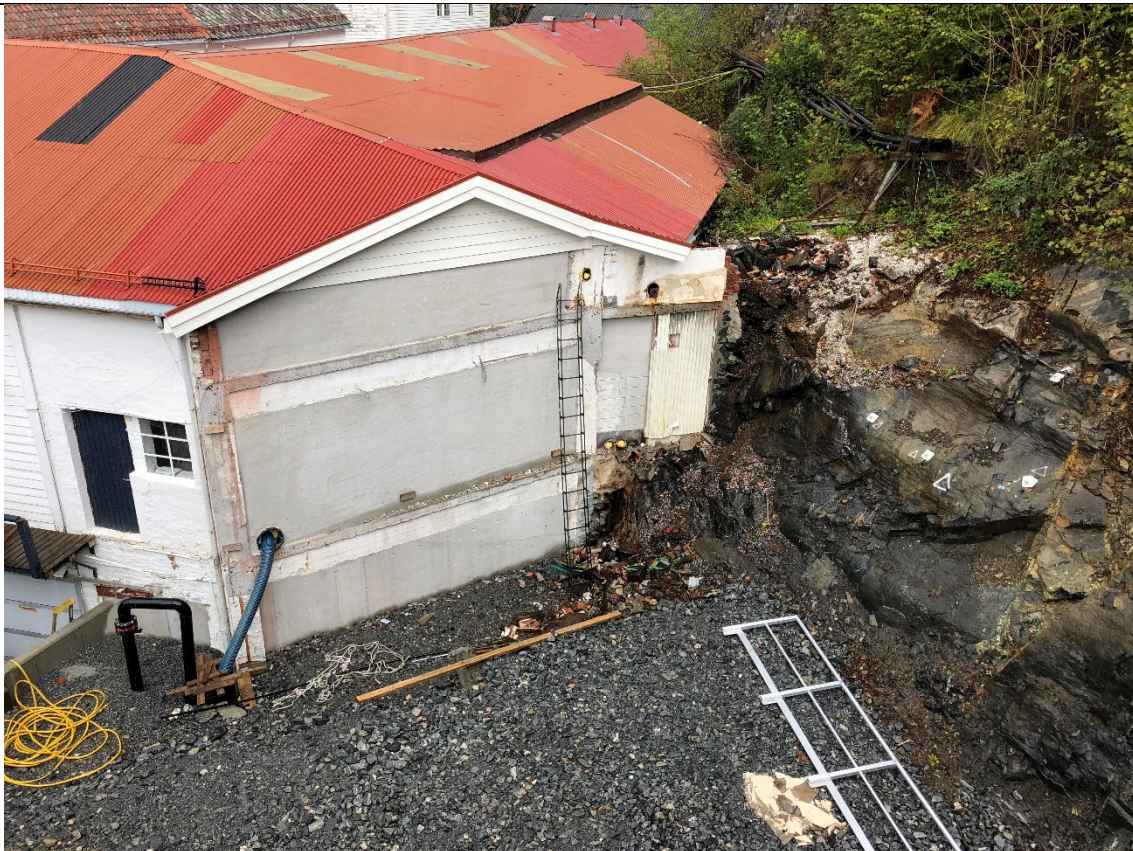
Dagens situasjon. Mur i leka er etablert som vegg mot eksisterande trebygg.
