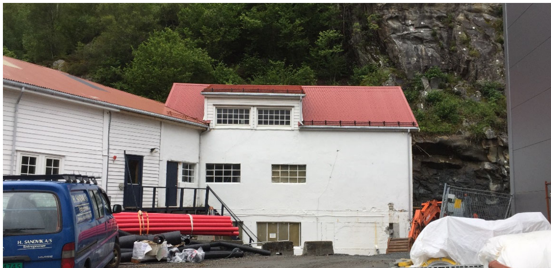
Front av Ishuset før riving. Bygget består av kjellar, 1. etasje og loftetasje med ark.
