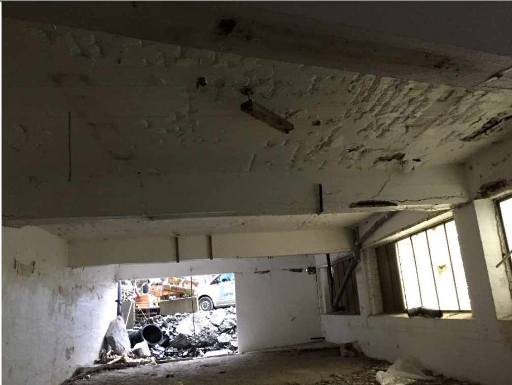
Kjellar etasje. Betonggol. Etasjeskiljar i betong. Bæresystem i betong. (jf. detalj frå kjeller under)
