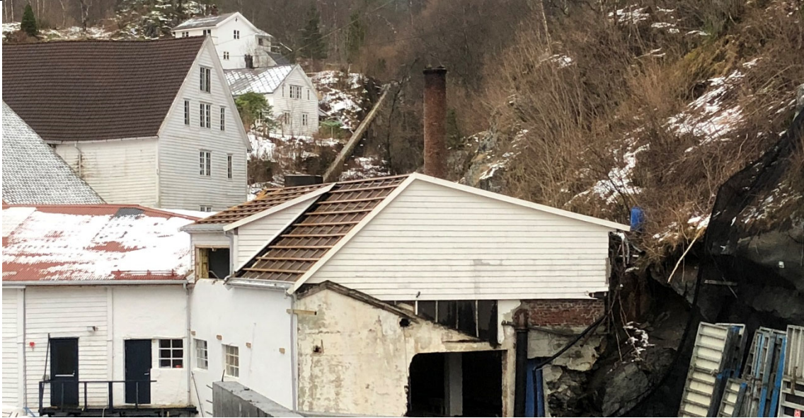
Riving av tak og vindauger. Taket vart oppgradert på 2000-tallet og gjer at takleker og sutak er moderne. Takrenne og nedløpsrør er også moderne og etablert i aluminium (galvanisert)
