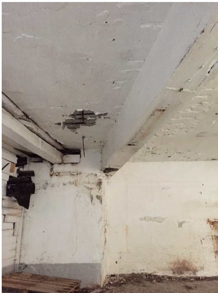
Kjellar etasje. Betonggol. Etasjeskiljar i betong. Bæresystem i betong. (jf. detalj frå kjeller under)
