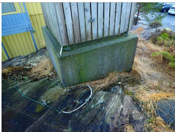
Bilde 2: Fundament til mast i betong
