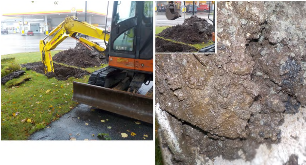
Figur 14. Bildene er tatt under sjakting i punkt 28. Sjakten ble 2,5 m dyp. Flere bilder er tilgjengelig på forespørsel.
