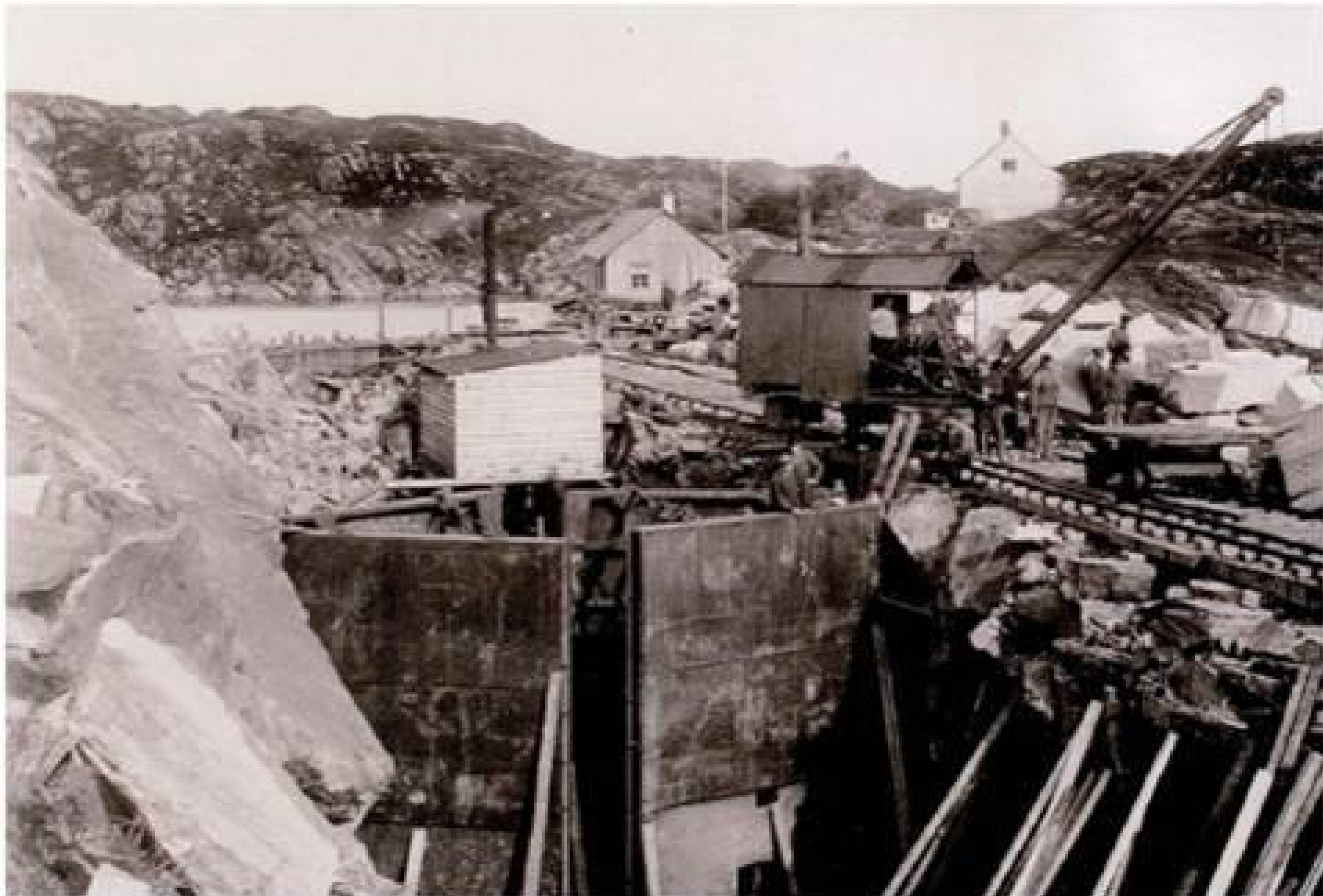
Bilete 21. Biletet viser byggjearbeida for Lindås sjøsluser. Vi ser at byggegropa er sprengt ned i Mølleholmen og sjøen er demt ute. Den eine doble sluseporten er i ferd med å komme på plass. Steinblokker til murararbeidet er på plass. Molna gard i bakgrunnen. Fotoet er henta i Riksarkivet.
