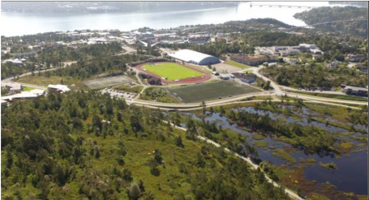
Figur 26. Knarvik idrettsanlegg sør for planområdet, med friidrettsbane, 11ar bane og 7ar bane. Dronefoto: Opus Bergen AS.
