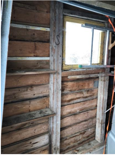
Vegg oppbygging garasje
