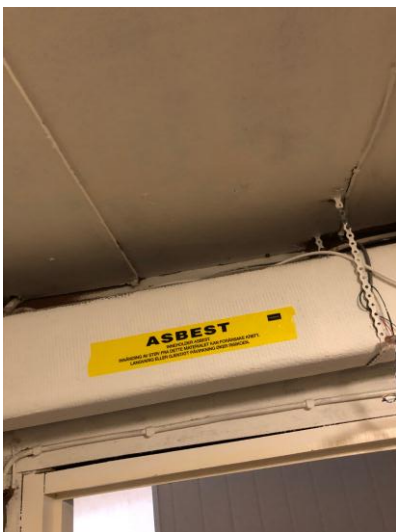
Ventilasjonskanal asbest
