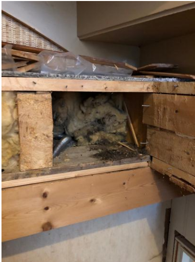
Oppbygging etasje skille
