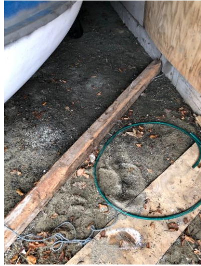
Gulv (sand) i garasje
