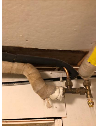
Prøvepunkt P2 av rørisolasjon
