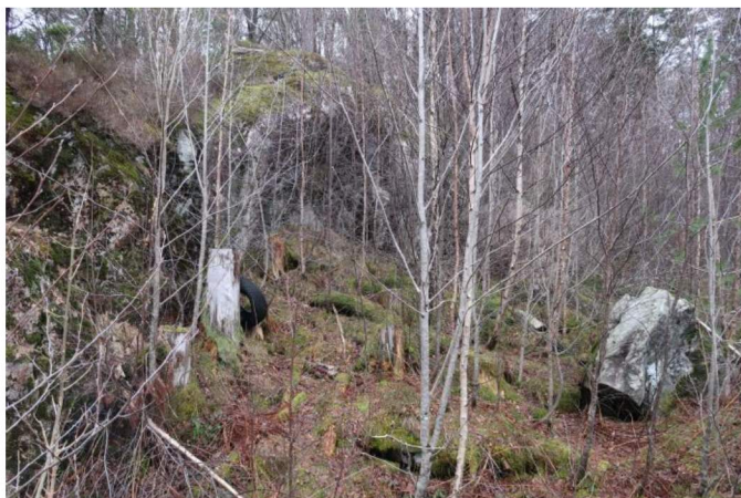
Figur 11. Bergskrent med ferske steinsprangblokker bak barneskolen.
