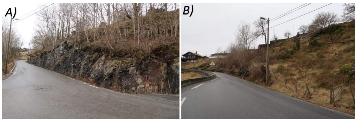
Figur 6. Skjæringer og terreng over Eidevegen. A) På det laveste punktet med avkjørsel til skolen, skjæring < 5m. B) Oppover mot bebyggelsen over Eidevegen, naturlig skrånning og lave skjæringer < 1,5 m.
