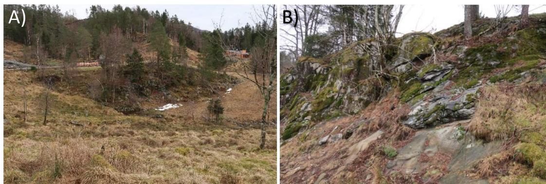
Figur 8. A) Myrområde som ender i en dalende med bergklippe. B) Utgående sprekkeplan gir avløsning av flak/blokker. Utraste blokker ligger der skrenten flater ut på myra.
