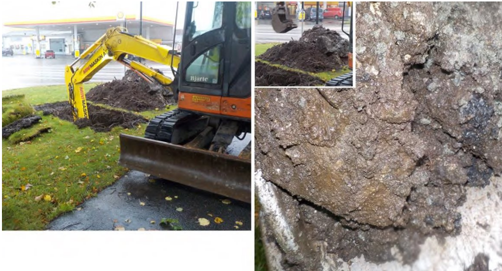
Figur 14. Bildene er tatt under sjakting i punkt 28. Sjakten ble 2,5 m dyp. Flere bilder er tilgjengelig på forespørsel.
