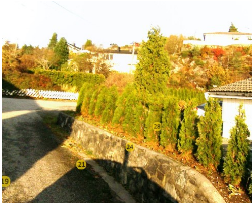
Bilete viser mur og hekk i siktsone til privat avkjørsle. Maks tillete høgde på mur, hekk og liknande er 0,5m over kommunalt vegnivå. Bilete er frå kommunen sine vegbilder frå 2015.
