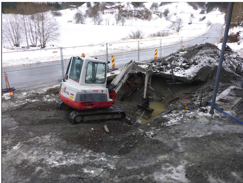
Figur 5 Oppgraving av nedgravde tanker og fjerning av sugeledninger. Foto: Multiconsult.
