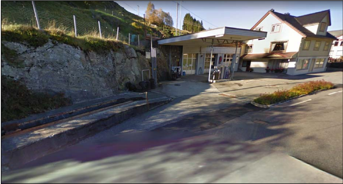
Figur 2 Stasjonen sett fra veien. (Kilde: www.google.maps.no ).
