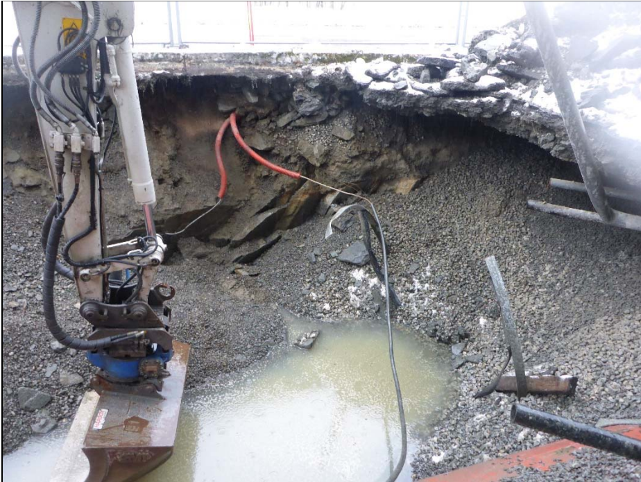
Figur 8 Stående vann i tankgropa. Vannet ble prøvetatt og det ble registrert lav nivåer av oljeforbindelser. Kilden til dette er mindre søl i forbindelse med arbeidene. Foto: Multiconsult.
