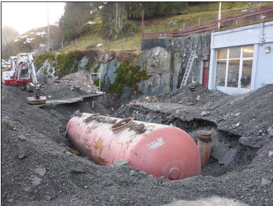
Figur 9 Pumpetak og pumpepalter ble revet for å kunne fjerne den siste tanken. Foto: Multiconsult.
