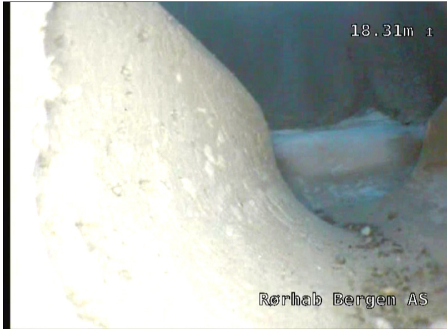
Foto: 4_1_4_07112017_203139_A.jpg 18,31m, Inspeksjon fullført -
