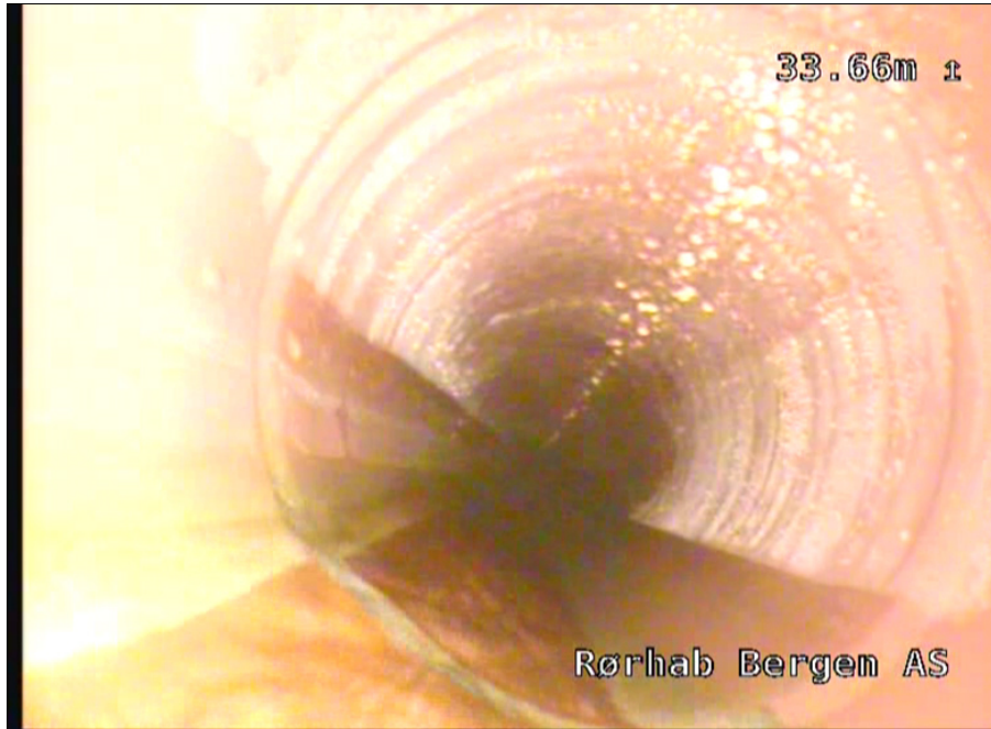
Foto: 1_1_3_07112017_195451_A.jpg 33,66m, Synlig pakning, Pakningsringen kan antydes i rørskjøt, 06 Kl.
