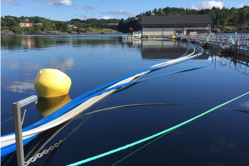
Foto 1. Fôrslangar sett frå nordleg merd
