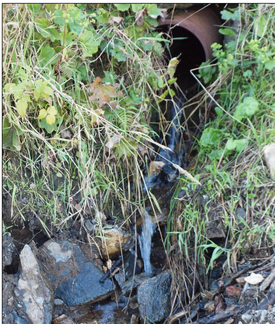
Figur 5-2. Nåværende dreneringsrør under vegen mot Li.
