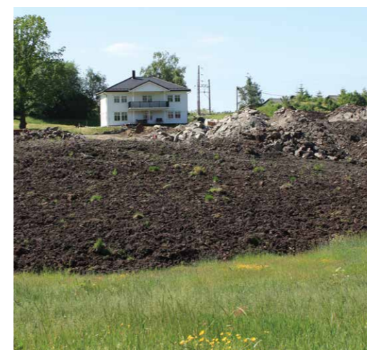
Overskotsmassar har gitt betre jordbruksareal på Mjåtveit og Langeland i Meland kommune
