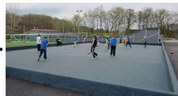
6) Gummidekke på 400m 2 for fotballdelen av Multibane inkludert markeringer for fotballmål
