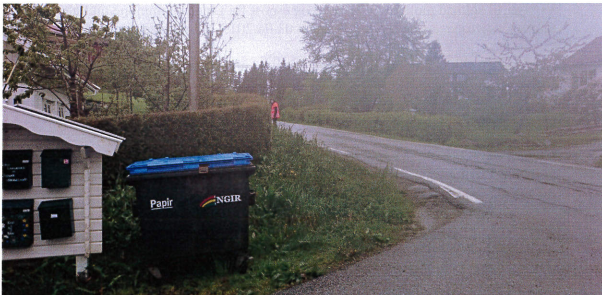
Bilde fra befarings: Hekk og bossdunk i frisiktsonen.
