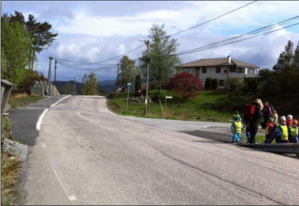
Figur 6.12. Fortau langs FV 391. Øvst til høyre: fortau midtre del. Øvst til venstre: fortau nordre del. Nedst: fortau ved skolen i sør
