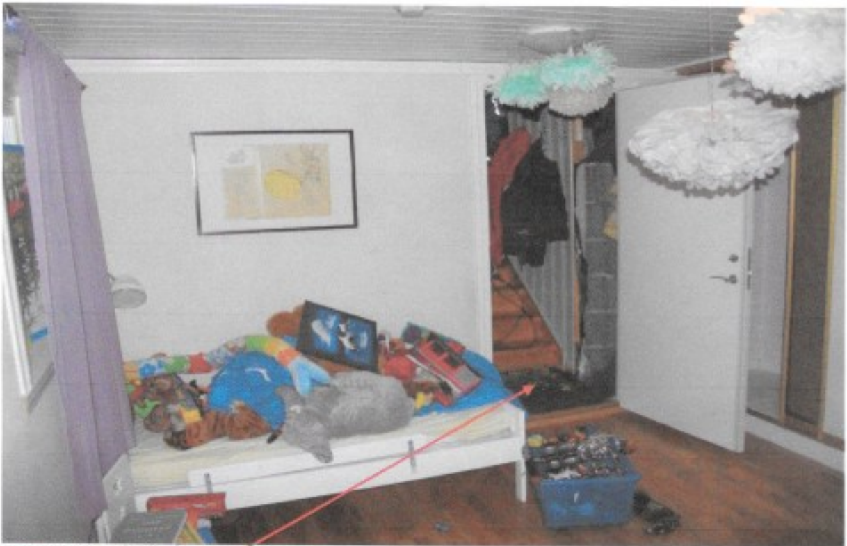
Bilde 40. Viser fukt på gulvstøp.
