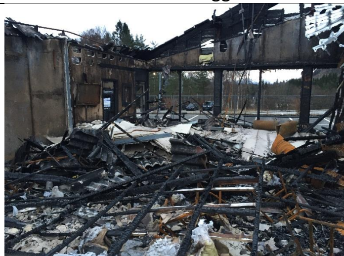
Mye knust asbest ligger blandet sammen med materialer på branntomten
