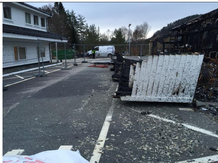
Asbest på asfalt mot hotell
