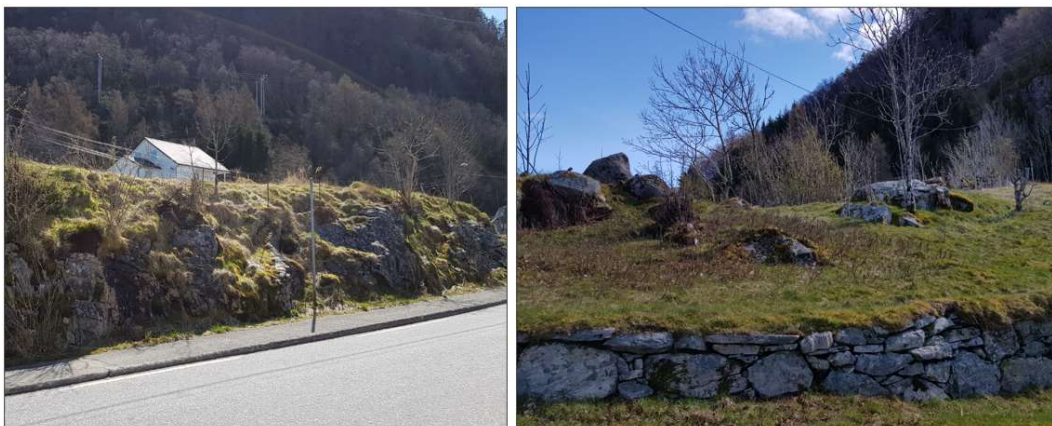
Figur 9: Bilder fra befarig 26.04.2021; til venstre fra område 4 og til høyre av område 5 i Figur 7.
