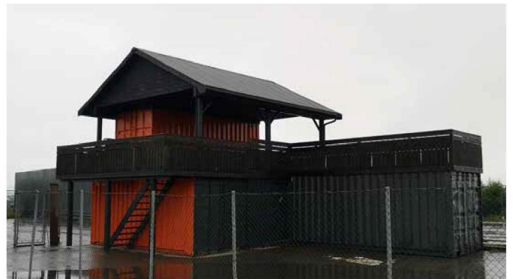
Røykdykkarhuset er langt på veg ferdigstilt
