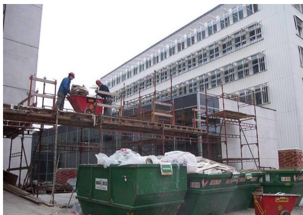
Bildet viser en byggeplass der avfallshåndteringen er planlagt slik at avfallet kastes ned i containere fra høyden. Restavfallsfraksjonen er plassert lengst unna for å stimulere til sortering. Foto: Sverre Valde.
