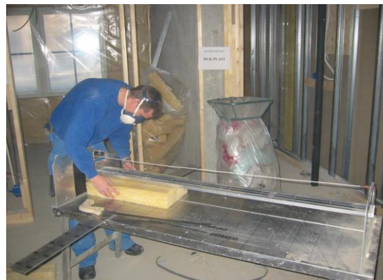
Bildet viser en ryddig arbeidsplass hvor avfallssekker for avkapp av isolasjon og plastfolie er plassert rett ved der avfallet oppstår, noe som gjør at det er lett å sortere avfallet. Foto: Sverre Valde.
