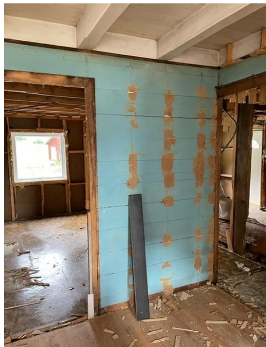
1. Etasje – golv, veggar og etasjeskilje
