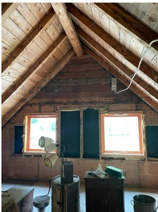
Loft-golv, veggar og yttertak
