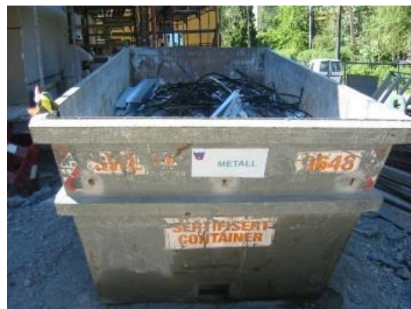
Det er viktig at containerne er godt merket, gjerne også med figurer eller bilder, slik at alle på byggeplassen, uavhengig av språk, kan forstå. Foto: Sverre Valde.
