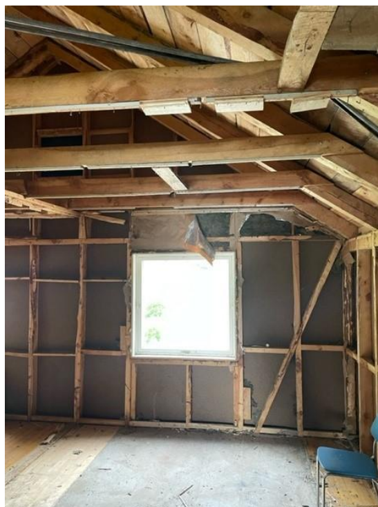
Tilbygg loft-golv, veggar og yttertak
