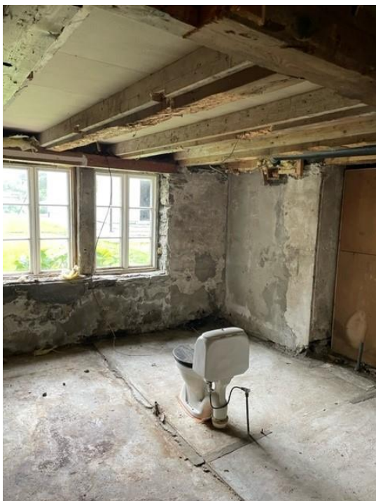
Kjeller - golv, vegger og etasjeskilje
