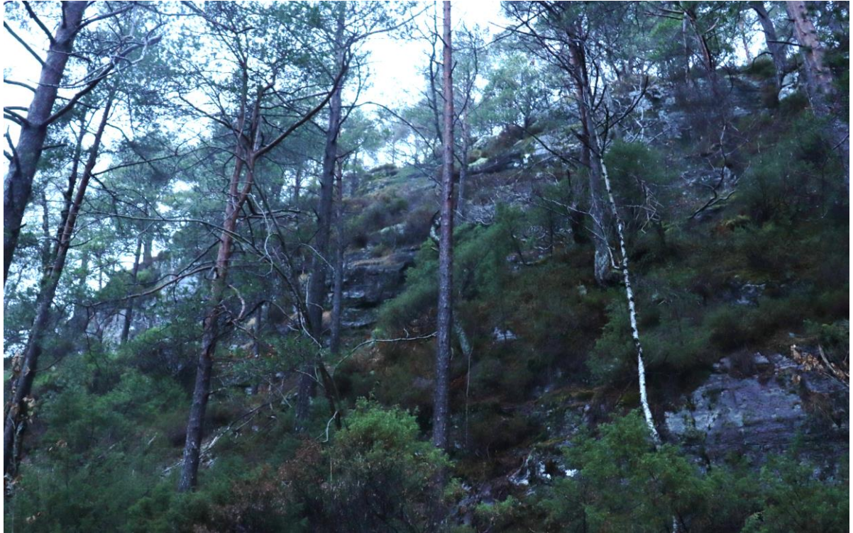
Figur 4. Bergskrenten opp mot Kvalhogen med avløste bergblokker og -flak.
