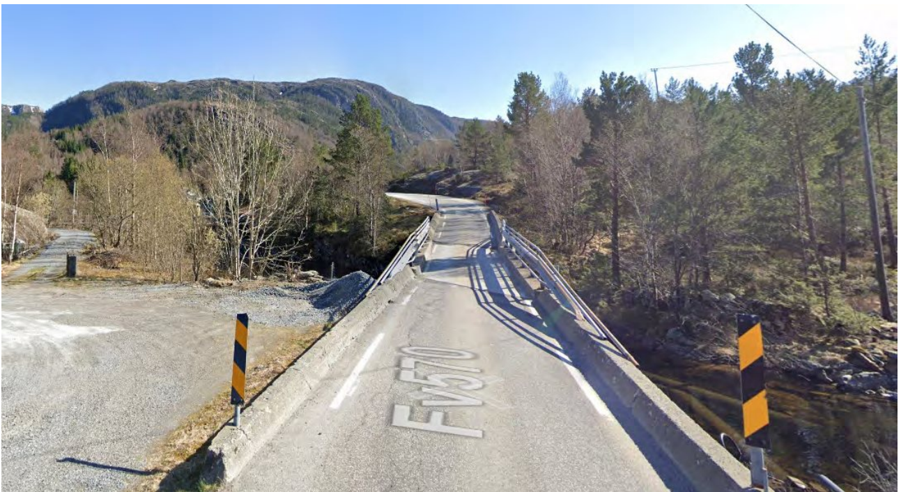
Tiltak 60 – Bru på Fv 570 Sørkvingo
