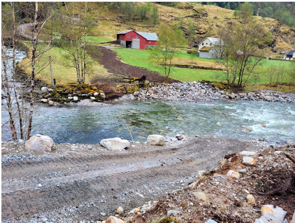
Bilde 7: Mellombels veg ved riggområde
