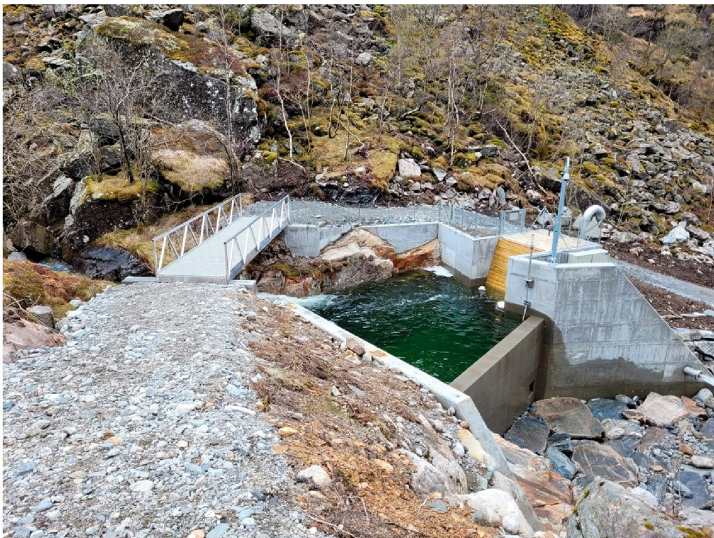
Bilde 1: Inntak og ATV-bru
