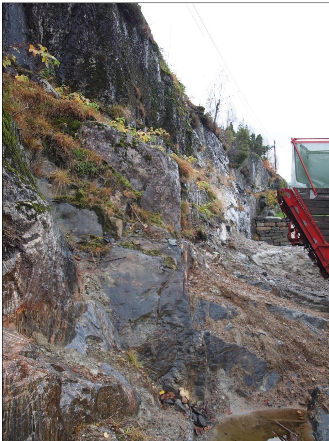
Figur 1-8. Bak-kant av aktuell tomt for bygning.
