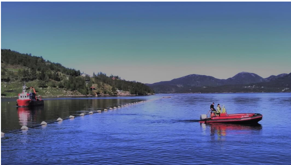
Figur 29: Senking av ny sjøleidning mellom Andvika og Mollandseidet i 2016
