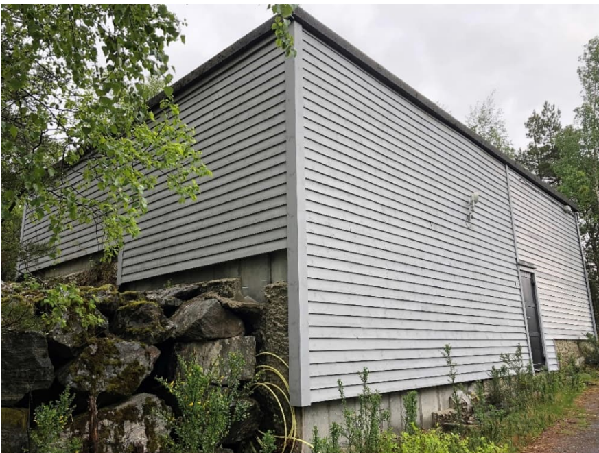
Figur 7: Høgdebassenget på Hosteland, eit plasstøyt basseng i betong på 430 m 3 .
