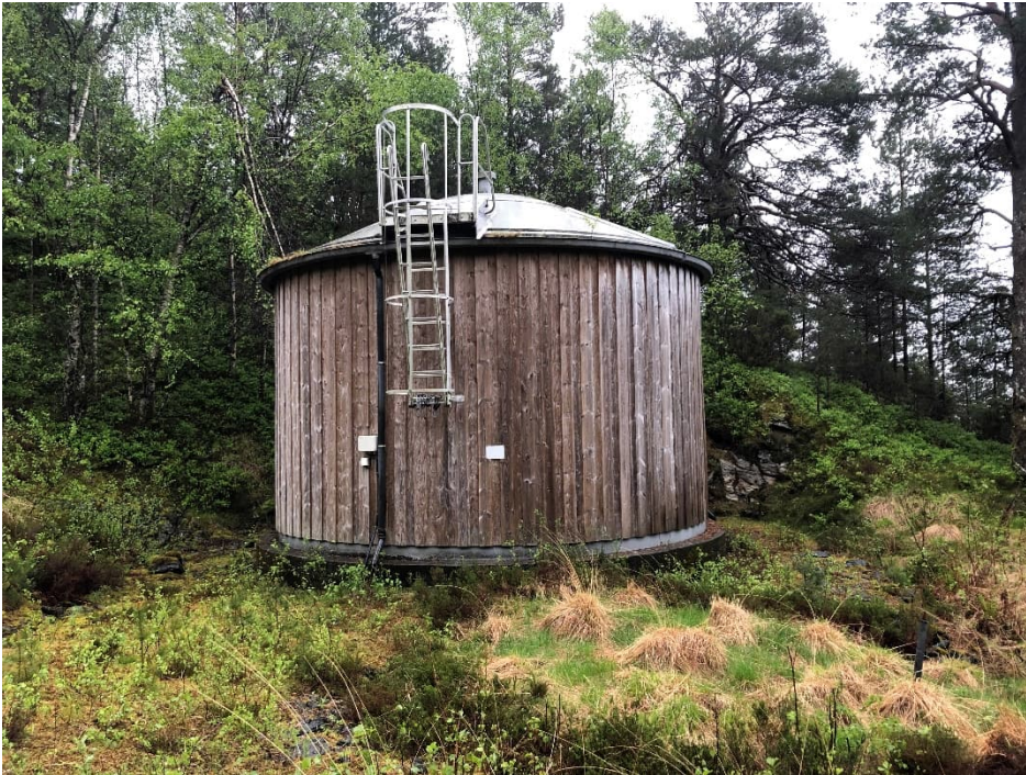
Figur 19: Høgdebasseng for Skolten vassverk
