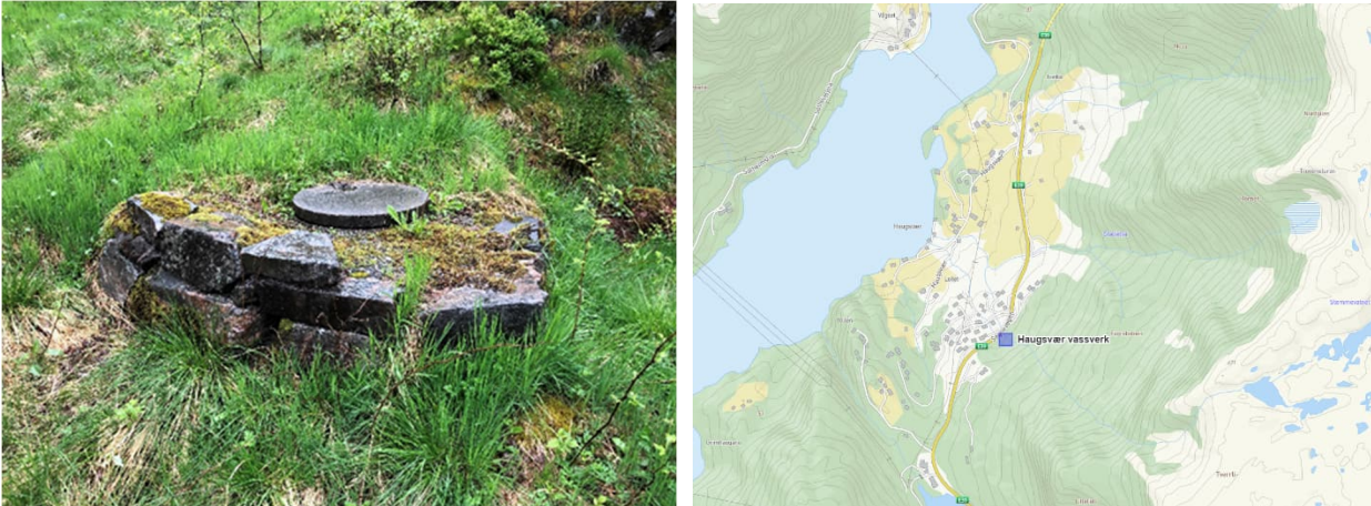
Figur 13: Eit av fire borehol i fjell på Haugsvær, samt oversiktskart
