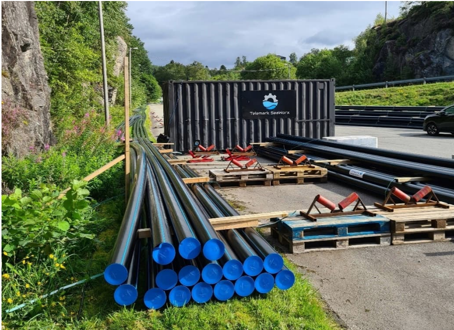
Figur 30: Rigg for sveising av nye PE-rør til sjøleidning mellom Mollandseide og Duesundøy.
