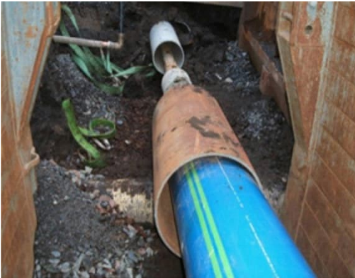
Figur 19: Eksempel på utblokking (kjelde: VA Miljøblad)
