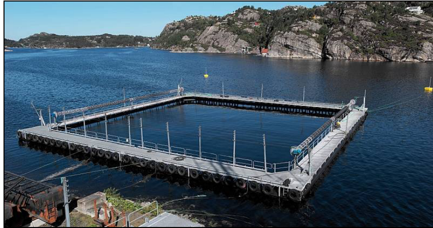
Figur 5. Anlegget vil bestå av to stk bur med innermål på 40x40 m utstyrt med miljøtromlar.
