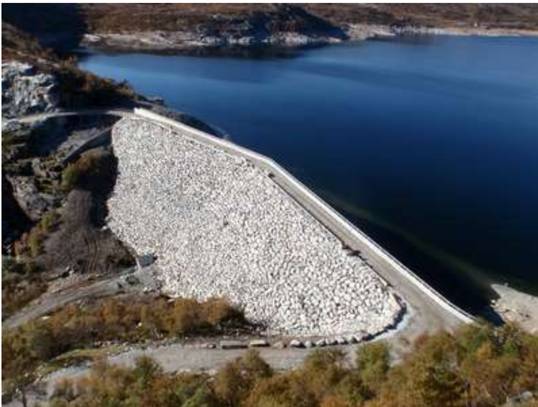
Fjellområda i indre delar av Nordhordland forsyner regionen med fornybar energi. Demning ved Krokevatnet i Masfjorden. Foto: BKK.
