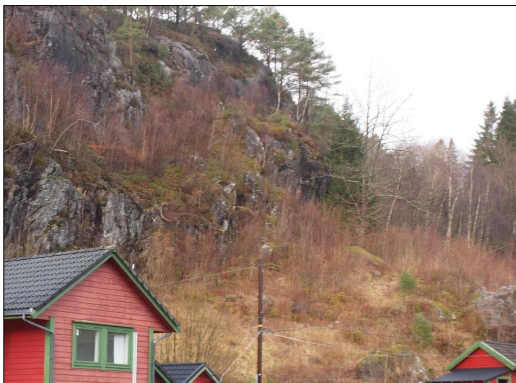
Figur 3-1. Vegetasjonen og topografi hindrer snøskred.
